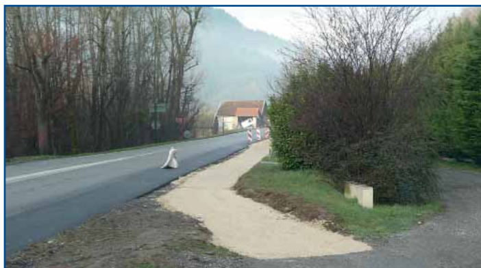
Amélioration passage piétons entre Sailles et Gerland ; l'enrobé a été réalisé
